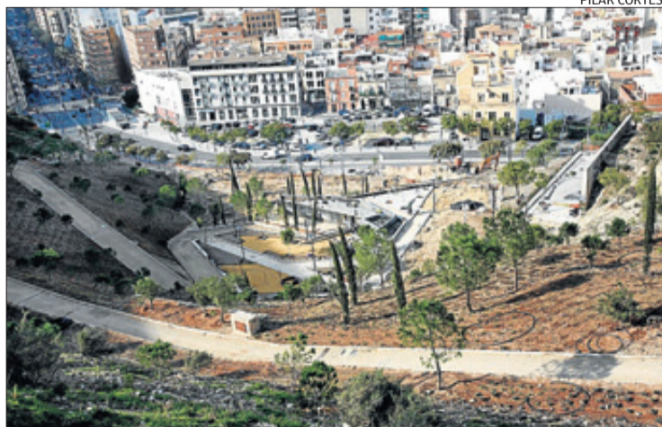
Obras de construcción del parque a las faldas del Benacantil
