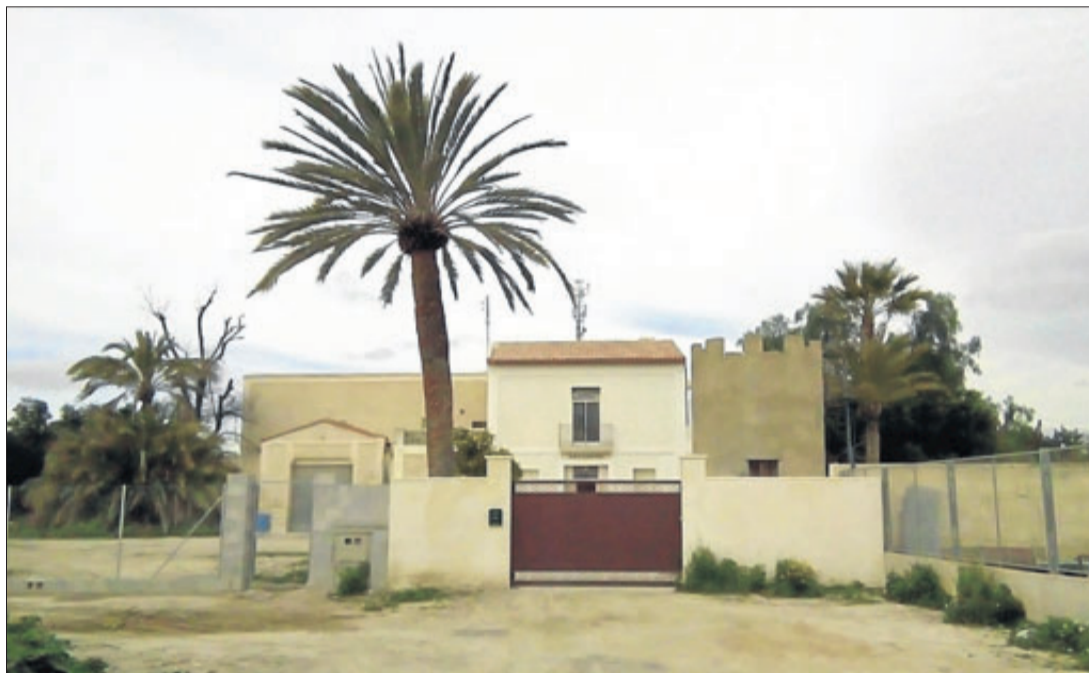
Casita Lozano, después de su restauración. ALFREDO CAMPELLO
