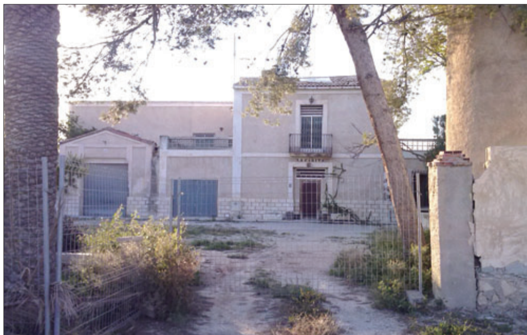
Casita Lozano, antes de su restauración. ALFREDO CAMPELLO
