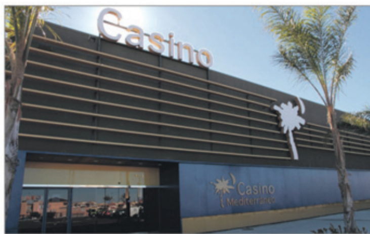
La instalación tiene una superficie de 1.200 metros cuadrados.
